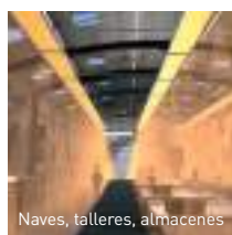
Naves, talleres, almacenes
