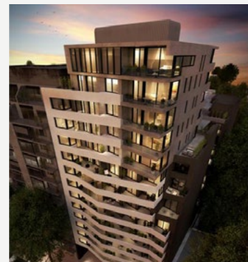
Argentina. Dome Green Soho
