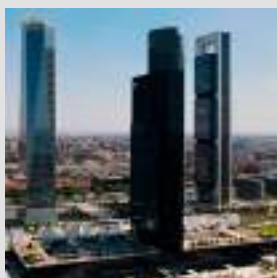
Torre Caleido (Madrid)
