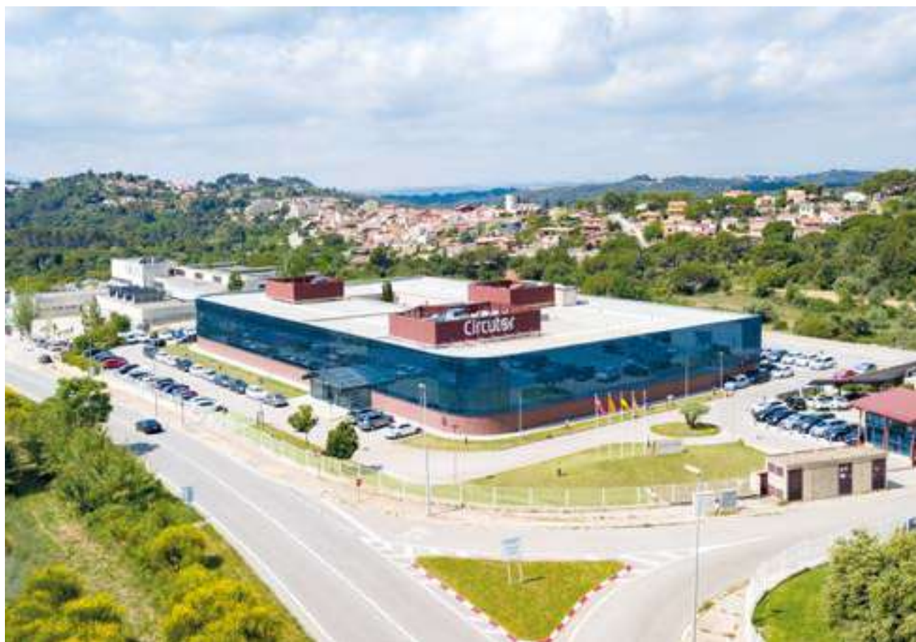
Sede central de CIRCUITOR en Viladecavalls, Barcelona.
